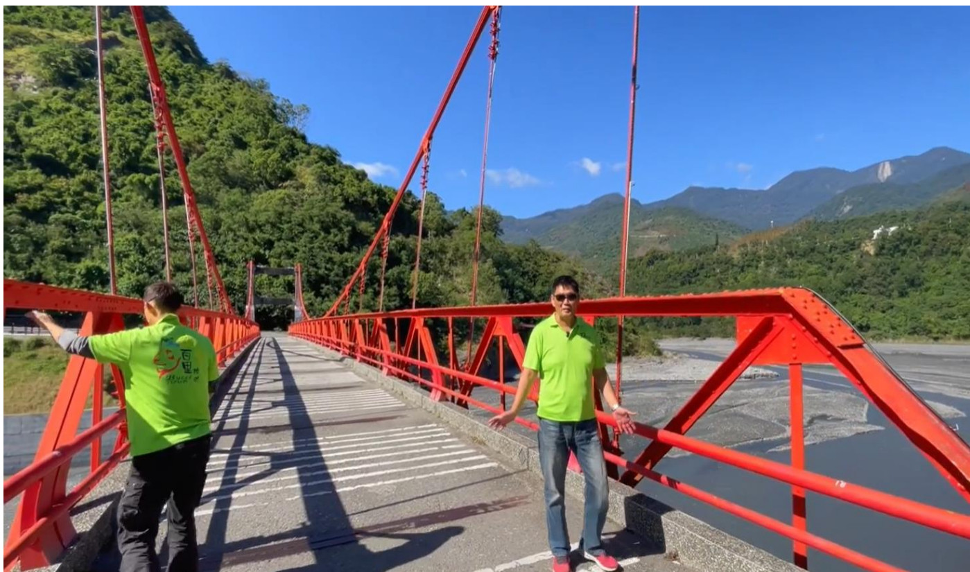
延鹿報報直播間第 23 集#鹿鳴吊橋
